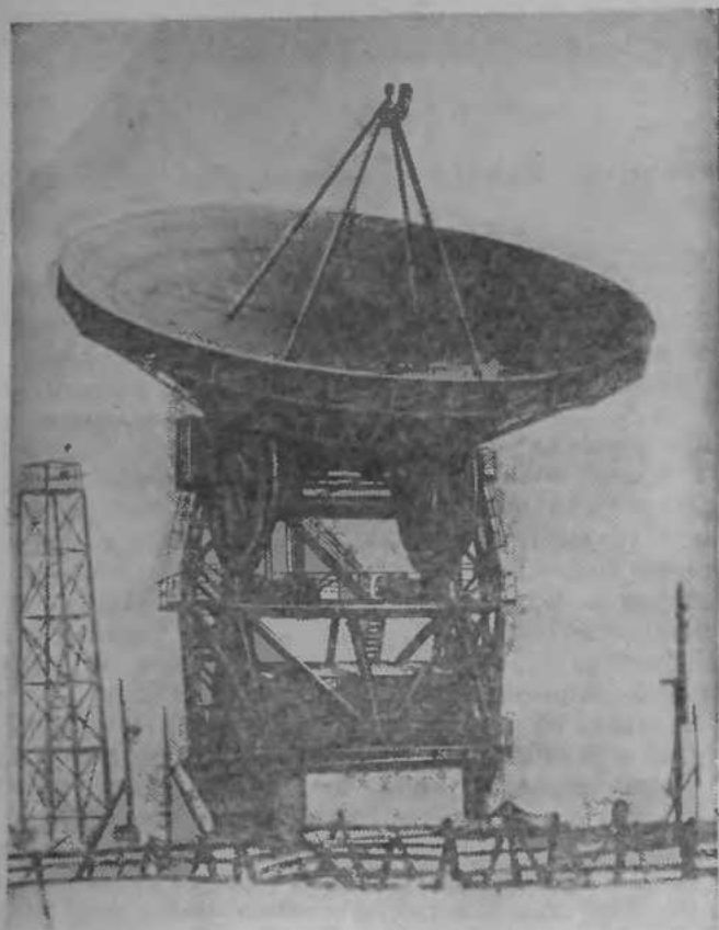
Рис. 72. Антенна радиотелескопа. Сигналы, принятые из дальних областей Вселенной даже такими громадными антеннами, вероятно слабы. Чтобы усилить их, нужны сверхчувствительные усилители. В качестве таких усилителей часто используются параметрические усилители, основным элементом которых является полупроводниковая емкость, периодически изменяемая внешним напряжением
